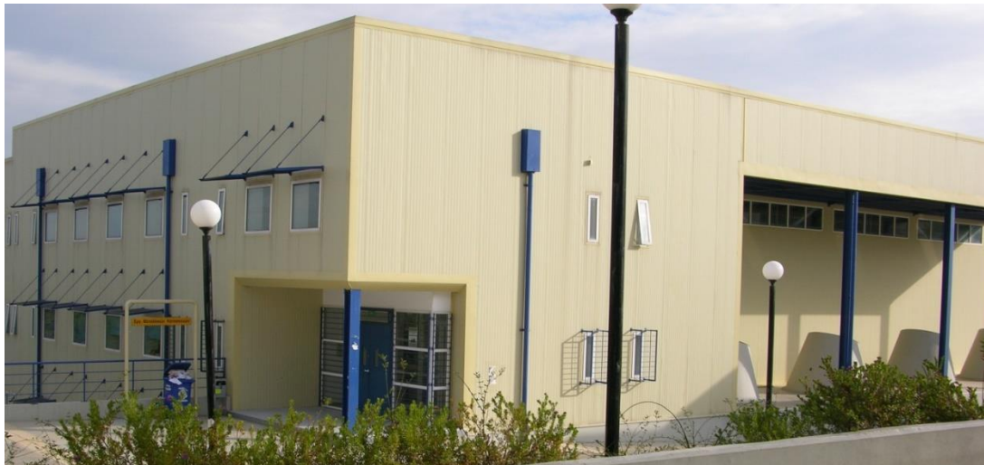
Κτήριο Εργαστηρίου Μεταλλικών Κατασκευών
