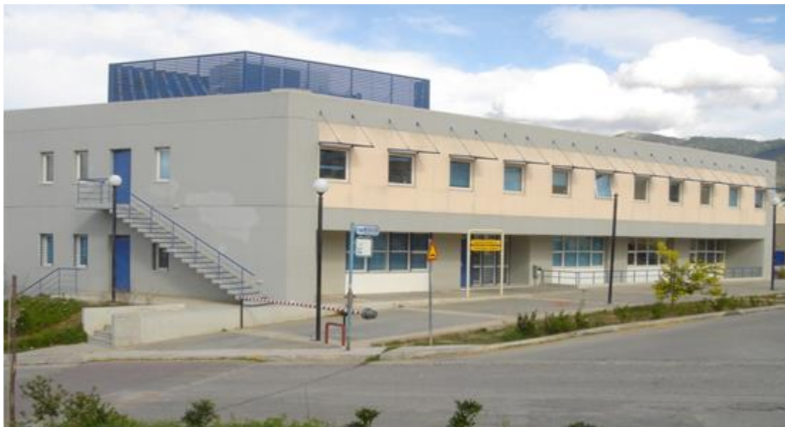
Κτήριο Εργαστηρίου Στατικής και Αντισεισμικών Ερευνών
