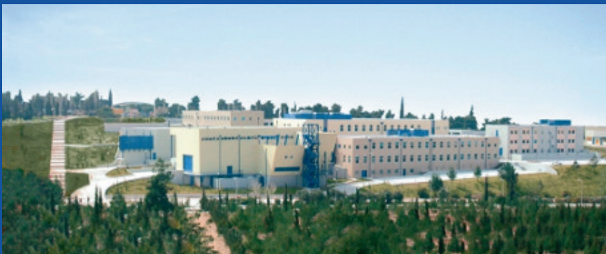
Τα νέα κτήρια της Σχολής Πολιτικών Μηχανικών στην Πολυτεχνειούπολη Ζωγράφου, όπου στεγάζεται η Σχολή από το 2003.
